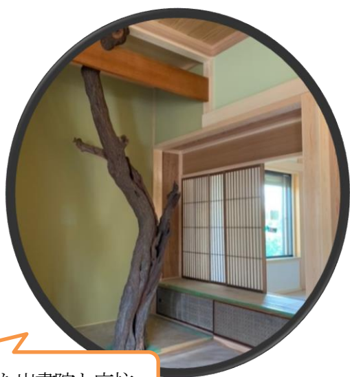
移設した出書院と床柱
